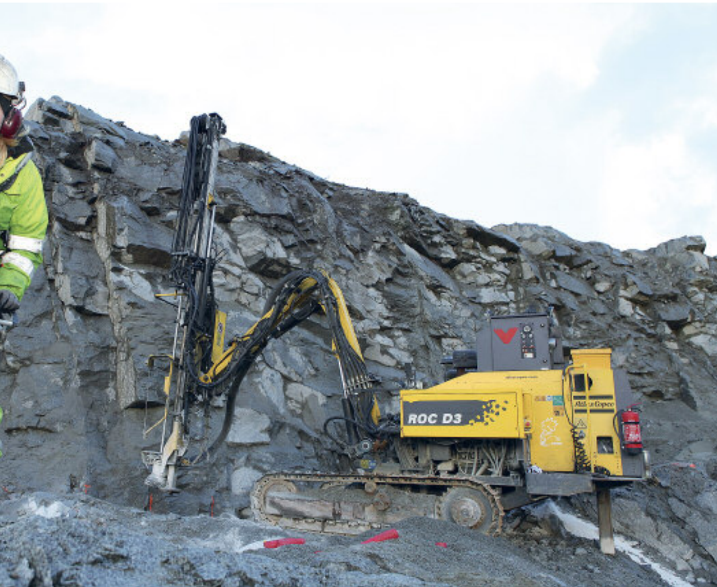
Hun kaster dynamittkubbene ut til hullene hvor de skal sprenges.
